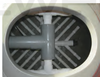
Onderloop collectoren systeem
